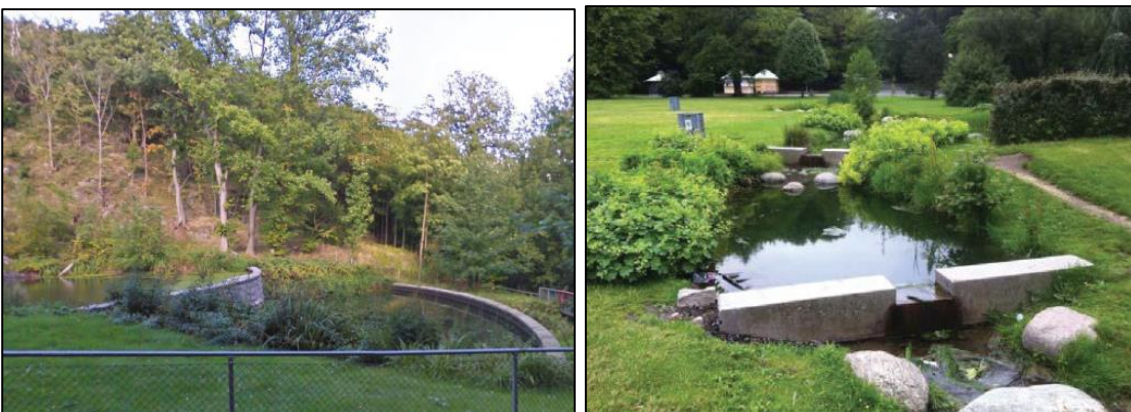
Figur 18. Fördröjande dagvattendiken/kanaler i Slottsskogen, Göteborg.
