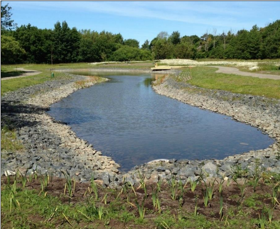
Figur 15. Exempel på dagvattendamm i Trönninge i Varberg (Foto: Norconsult).
