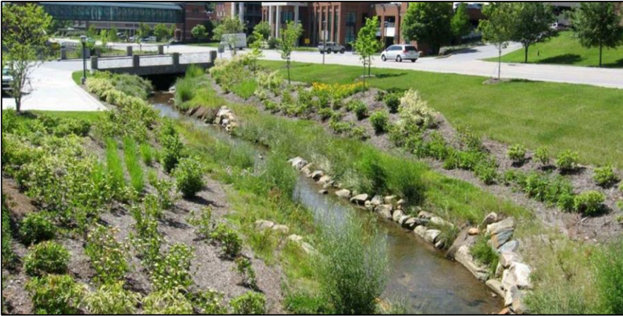
Figur 16. Exempel på ett vattenförande svackdike (Boone creek) men vegetation i slänterna (Foto: Appalachian State).
